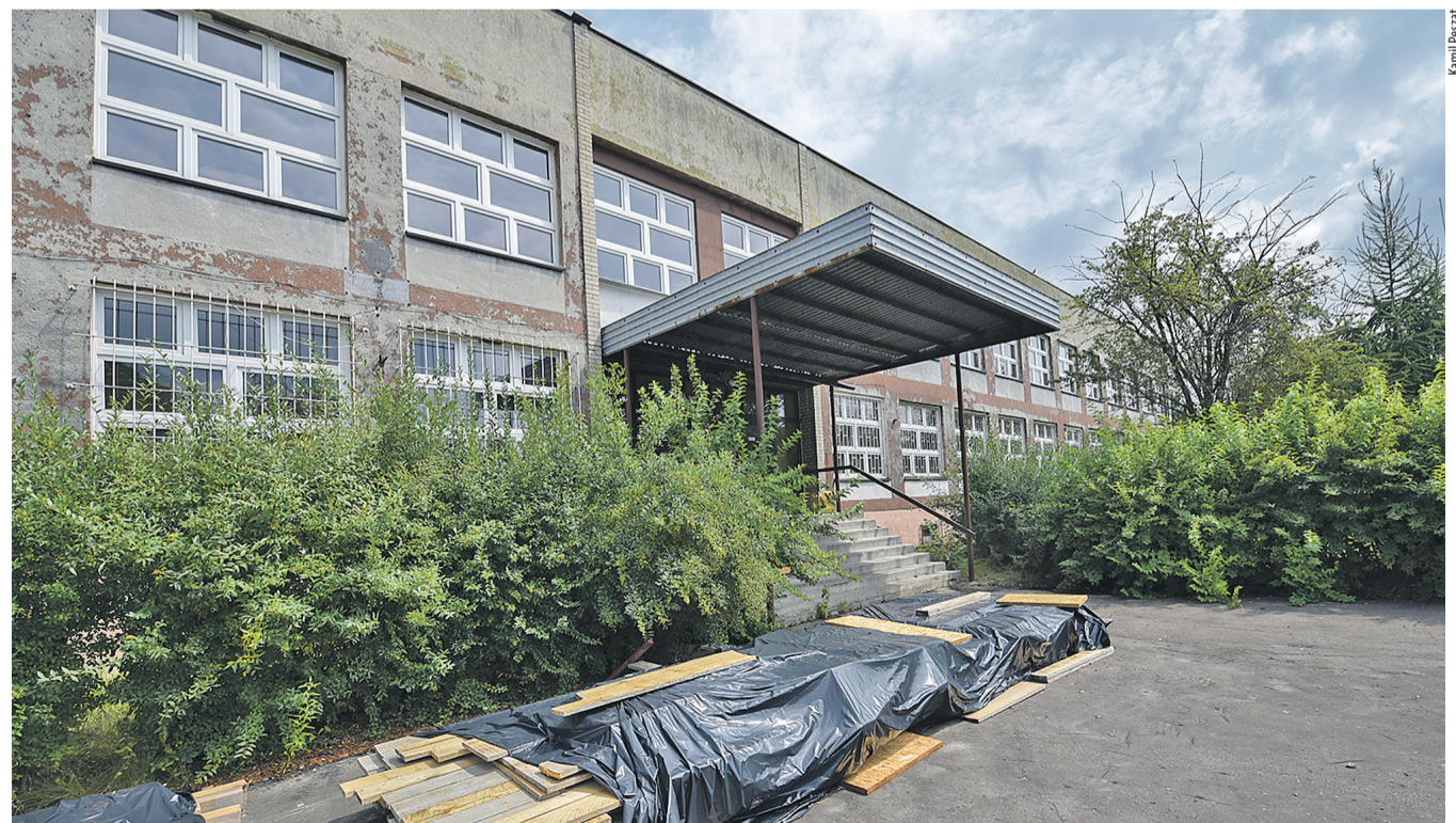
W budynku przy ul. Edukacji 11 rozpoczęły się prace adaptacyjne. W przyszłym roku powstanie tam CUS.
