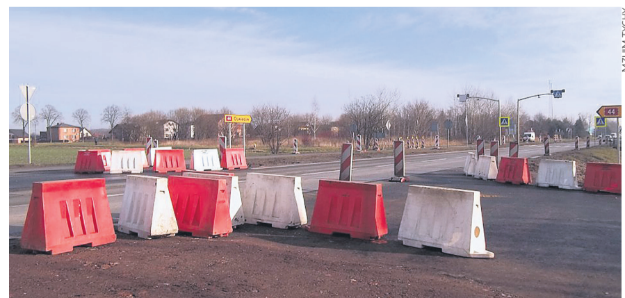
Podczas przebudowy DK44 kierowcy korzystają z tymczasowego ronda.
