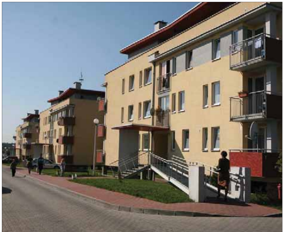
Nowe bloki powstały także przy ul. Jaskowickiej
