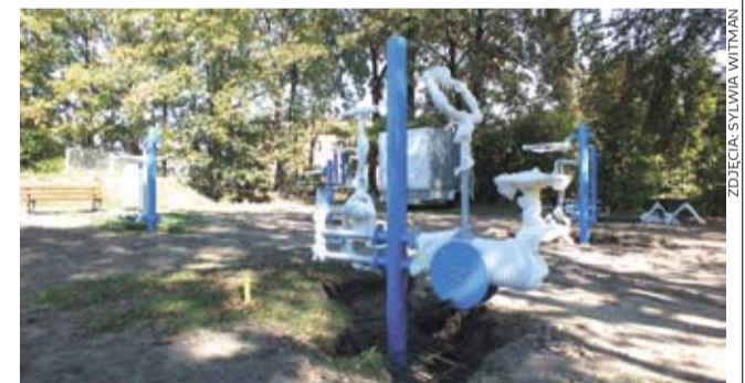
W kilku miejscach, m.in. przy ul. Norwida trwa montaż siłowni plenerowej.
