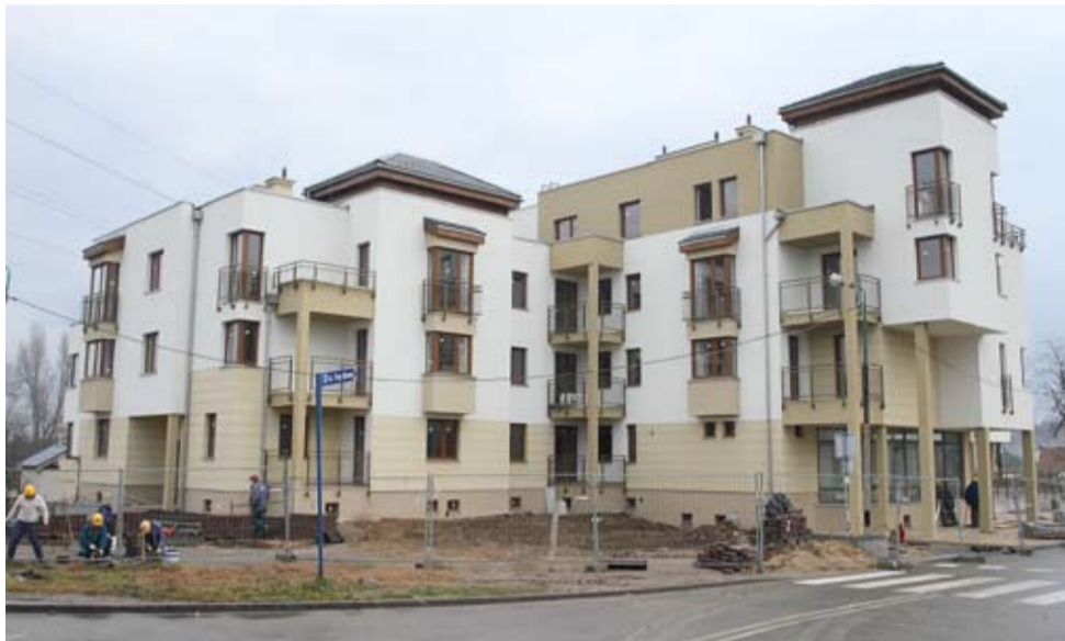
W najbliższych tygodniach ukończona zostanie budowa nowych mieszkań TTBS przy ul. Grota-Roweckiego.
