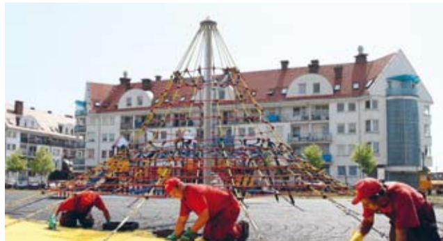
Większość urządzeń jest już zamontowana.
