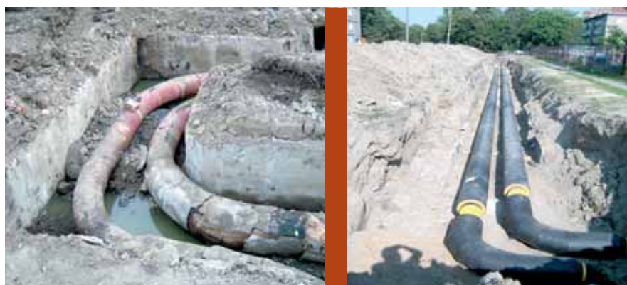
Fragment sieci ciepłowniczej przed i po modernizacji
