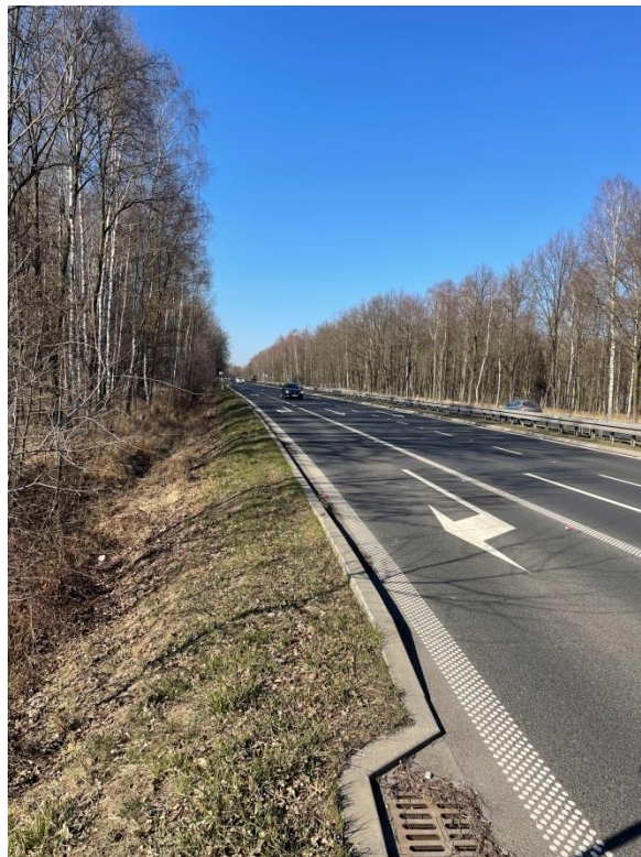
Rys. 5. Widok drogi krajowej nr 86 w rejonie północnej granicy miasta (źródło: zasoby własne Wykonawcy).
