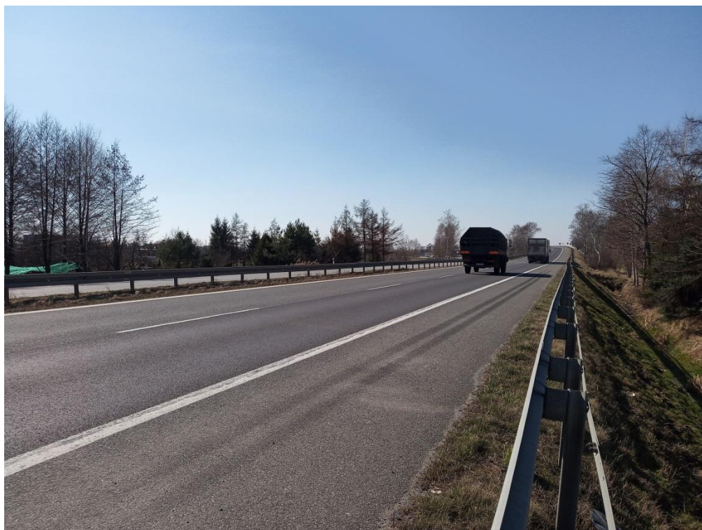
Rys. 4 Widok trasy ekspresowej S1 w rejonie ul. Paproci (źródło: zasoby własne Wykonawcy).
