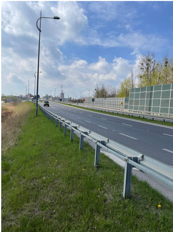
Rys. 2. Widok drogi krajowej nr 1 w rejonie węzła z Al. Niepodległości (źródło: zasoby własne Wykonawcy).
